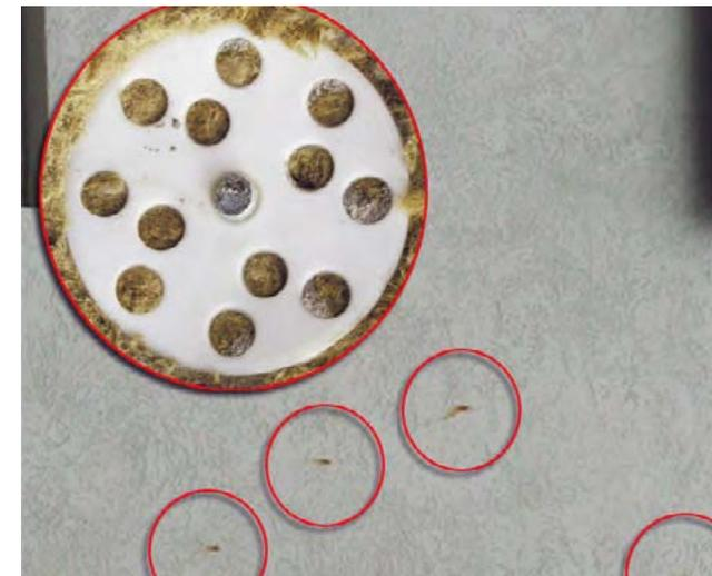
Удельный геометрический показатель тарельчатого элемента весьма велик и на практике колеблется в пределах от 5 до 12 шт/м<sup>2</sup>, по этому, даже при относительно малых значениях удельных теплопотерь через еденичный элемент, учет их обязателен.
